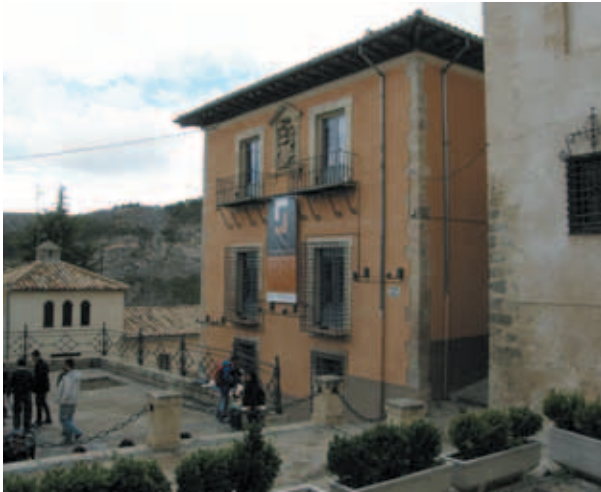
Fachada lateral de Casa Zavala, sede de la Fundación Antonio Saura.
